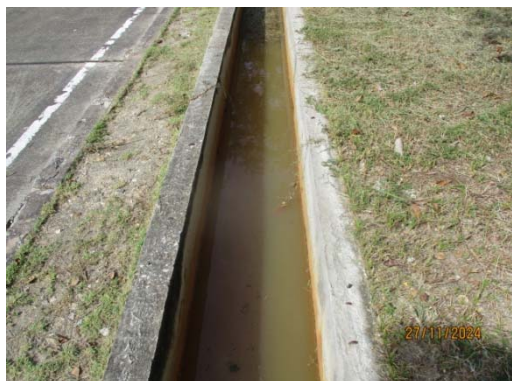
รูปที่ 12 ร่องระบายน้ำฝนภายในพื้นที่โรงงาน ที่แยกออกจากร่องระบายน้ำเสีย
