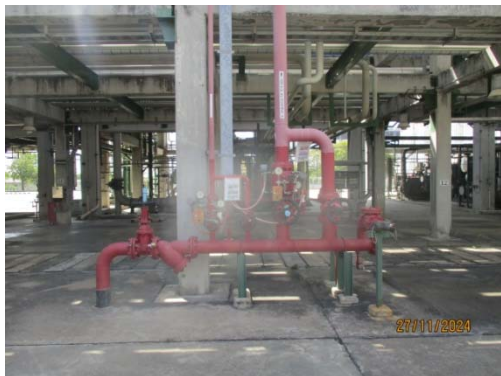
รูปที่ 47 ระบบน้ำดับเพลิง (Deluge System)
