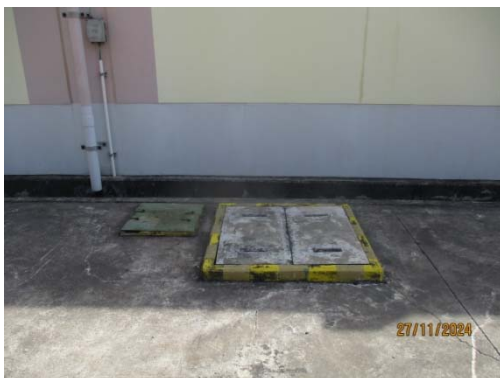
รูปที่ 10 ถังบำบัดน้ำเสียสำเร็จรูป บริเวณอาคารสำนักงาน
