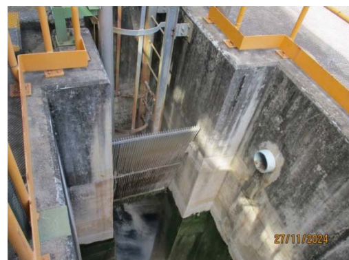
รูปที่ 11 จุดบำบัดด้วยตะแกรงละเอียด ก่อนระบายน้ำเสียไปยังบ่อ API
