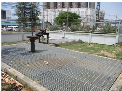
รูปที่ 11 บ่อดักตะกอนบริเวณรางระบายน้ำฝน
