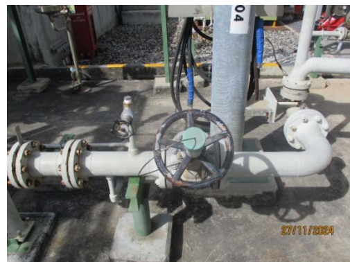
รูปที่ 74 Shut off Valve
