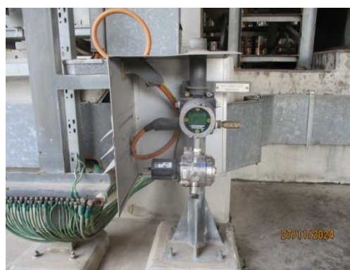
รูปที่ 52 Gas Detector
